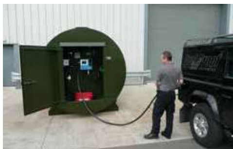
Låsbart skap i full høyde for enkel tilgang til pumpeutstyr og tanktilkobling
